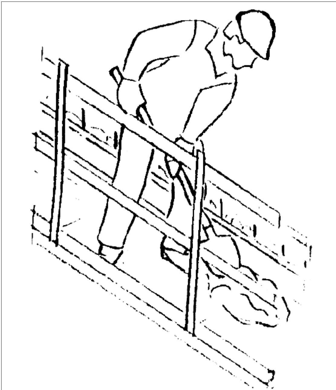
Рис.6. Очистка лопатами просыпавшегося бетона с деревянного настила подмостей и опалубки
