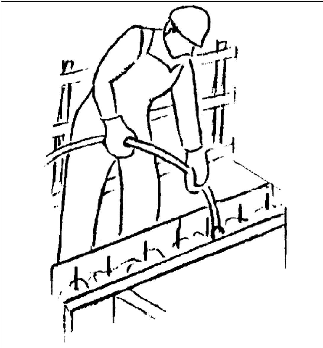
Рис.9. Уплотнение уложенных слоев бетонной смеси глубинными или поверхностными вибраторами
