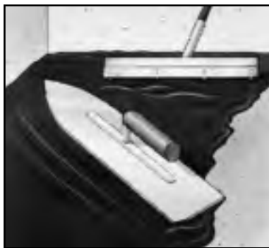
Рисунок 25. Распределение растворной смеси.
