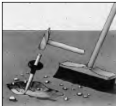
Рисунок 17. Удаление непрочных участков поверхности основания.
