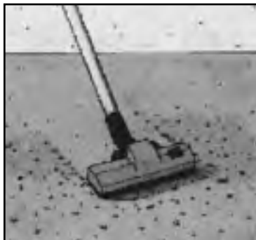
Рисунок 6. Обеспыливание основания.
