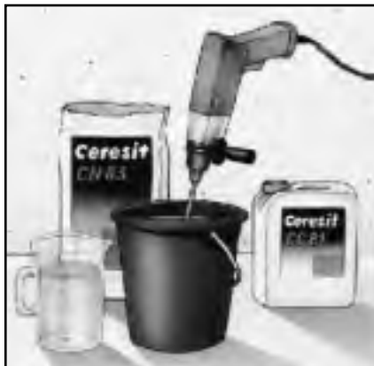
Рисунок 11. Приготовление адгезионного слоя.
