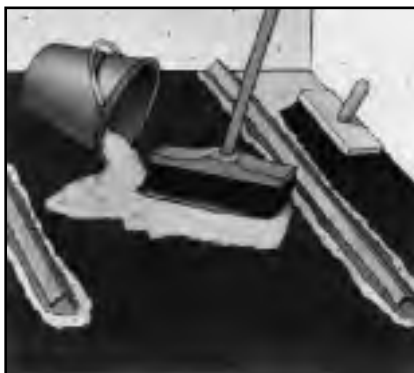
Рисунок 12. Нанесение адгезионного слоя.
