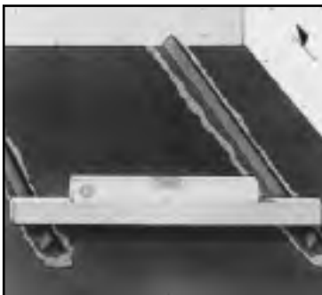
Рисунок 8. Изготовление направляющих полос.
