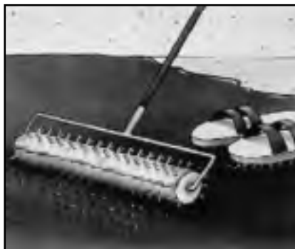
Рисунок 26. Распределение смеси игольчатым валиком.
