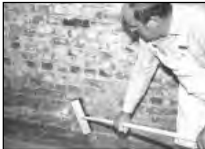
Рисунок 8 - Удаление непрочных участков в гидроизолируемой поверхности.
