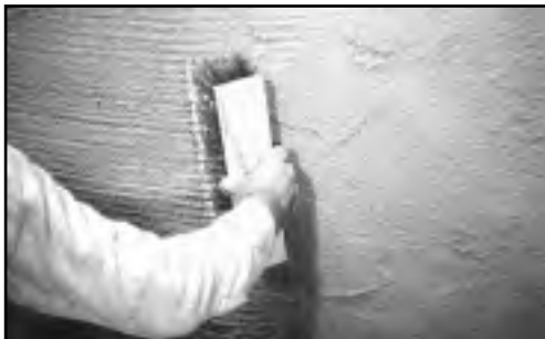
Рисунок 12 - Нанесение первого слоя гидроизоляции.
