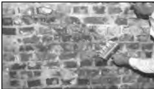
Рисунок 10 - Нанесение грунтовки с помощью кисти.
