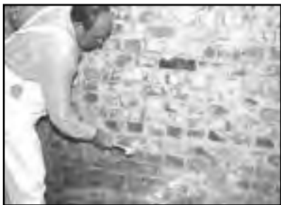
Рисунок 8 - Удаление непрочных участков в гидроизолируемой поверхности.
