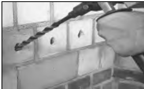
Рисунок 14 - Подготовка конструкции под гидрофобизацию.
