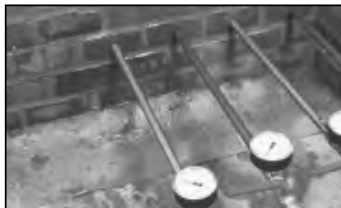
Рисунок 15 - Подача гидрофобной жидкости в "тело" конструкции.
