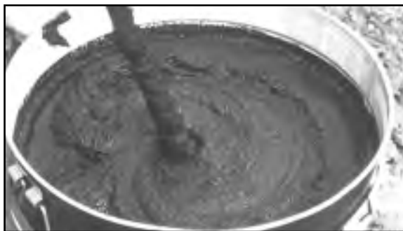
Рисунок 11 - Приготовление растворной смеси
