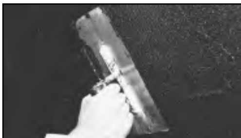
Рисунок 13 - Нанесение третьего слоя гидроизоляции.
