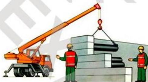
Рис.19. Передача сигналов в ограниченной зоне видимости
