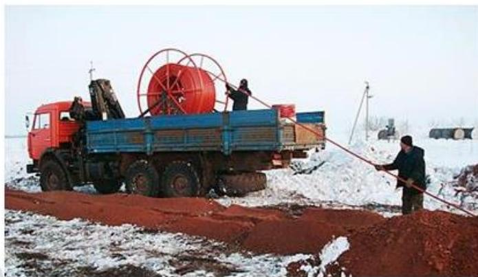
Рис.12. Прокладка кабеля в траншеею с автомобиля
