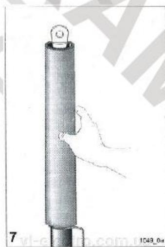
Усадить трубку сначала в области среза полупроводящего экрана, используя мягкое пламя горелки желтого цвета. Затем продолжить усадку в направлении наконечника и в последнюю очередь усадить трубку на наружный покров. Последовательность усадки показана на рисунке цифрами.
