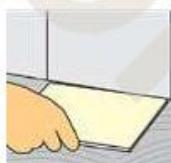
Первый ряд плитки положить по центральной линии помещения. Для этого – в прямоугольных помещениях – натянуть шнур в центре параллельно стенам. Первый ряд плитки выравнивается по шву или по центру плитки. Затем плитки укладываются вдоль стены.
