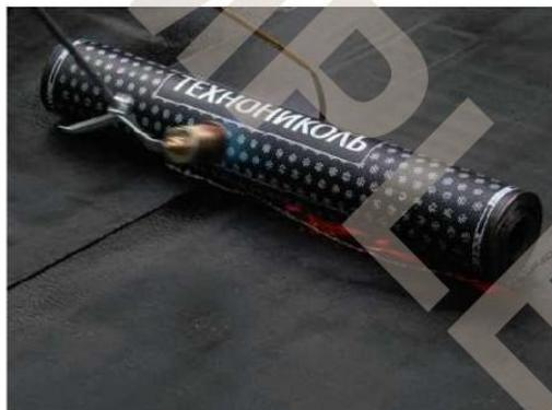
Валик расплавленного битумно-полимерного вяжущего
